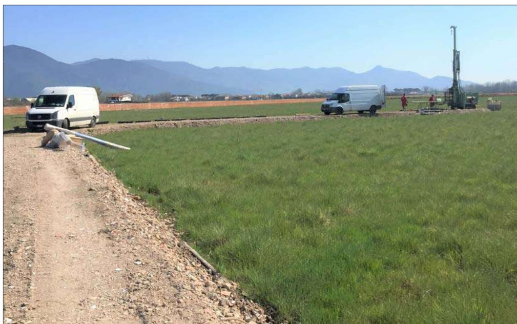
Postazione del sondaggio S1.
