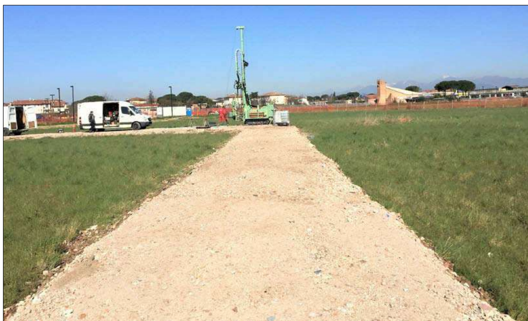
Postazione del sondaggio S2.
